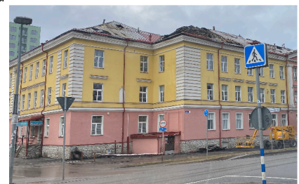
Seurakuntakodin naapuritalon ullakkokerroksen asunnot tuhoutuivat palossa ja vesivahinkoja kärsi koko rakennus.
